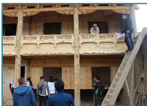
传统建筑勘察现场
